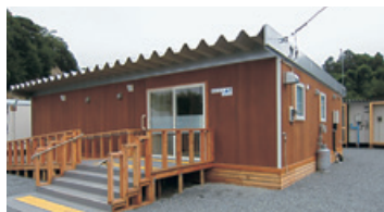
復興ボードを用いた仮設集会施設
