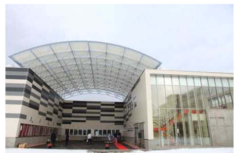
竣工したものづくり研究棟
