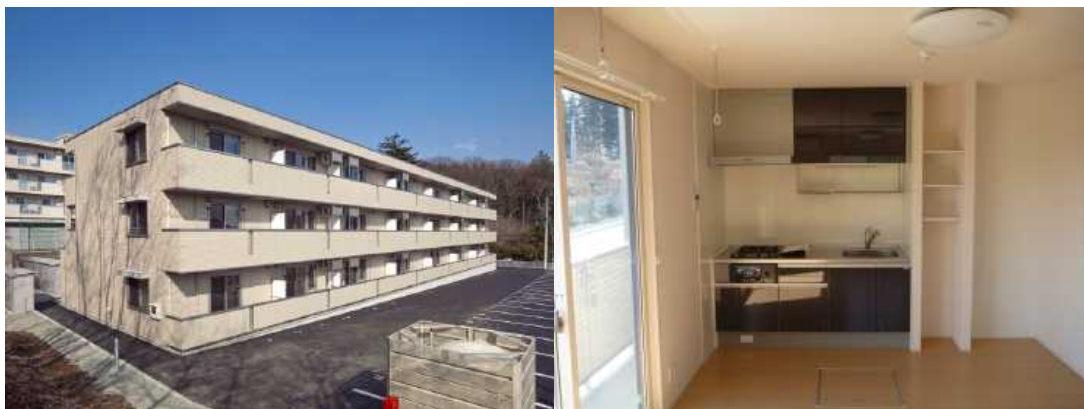
竣工した北山職員住宅「ノースヒルズ北山」
